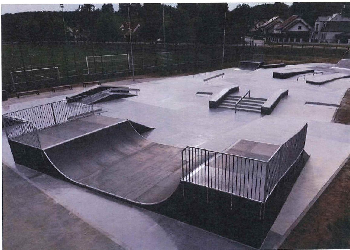
fot. budowa skateparku w Świerznie (zdjęcie pogładowe)
