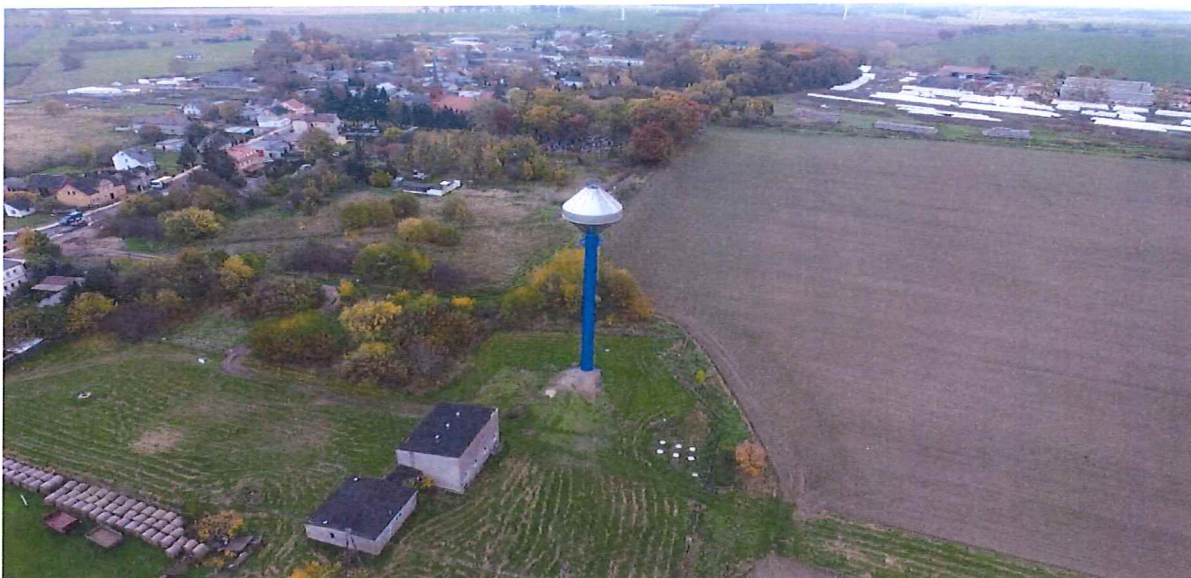
fot. odnowiona wieża ciśnienia w Gostyniu
