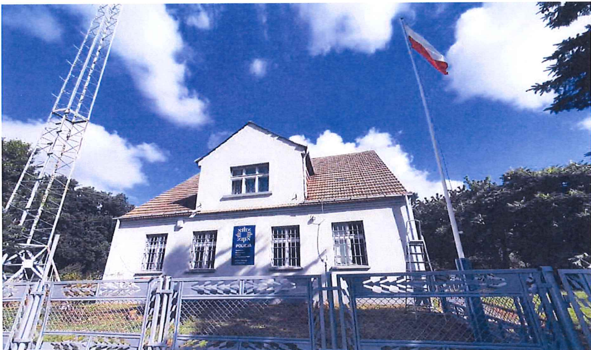
fot. wyremontowany budynek Posterunku Policji w Świerznie
