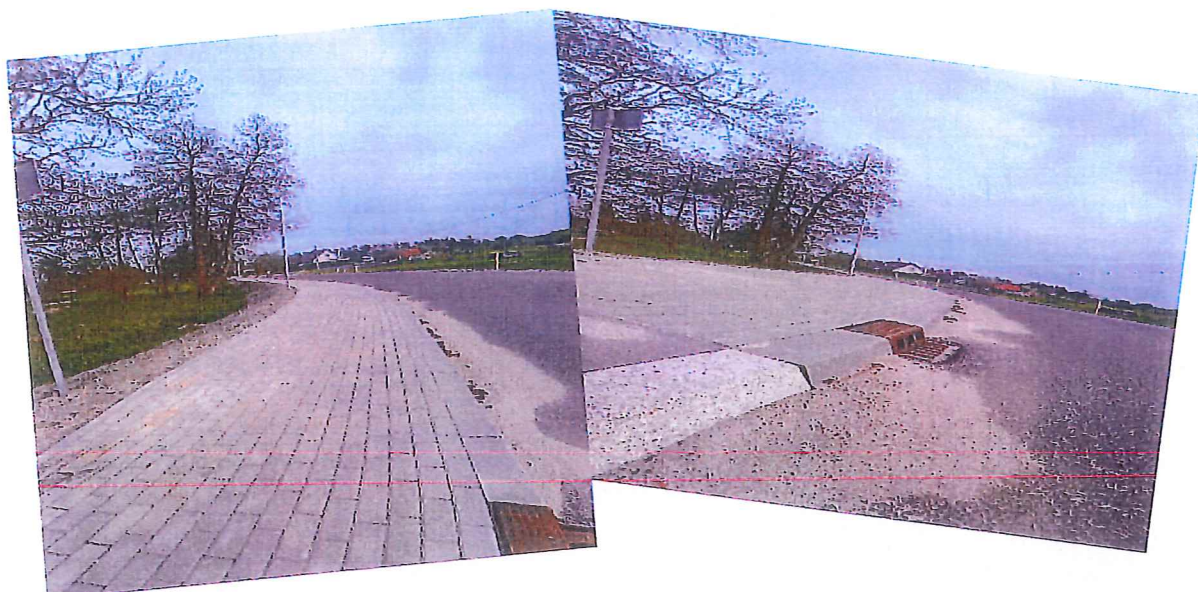
fot. budowa chodnika w Jatkach
