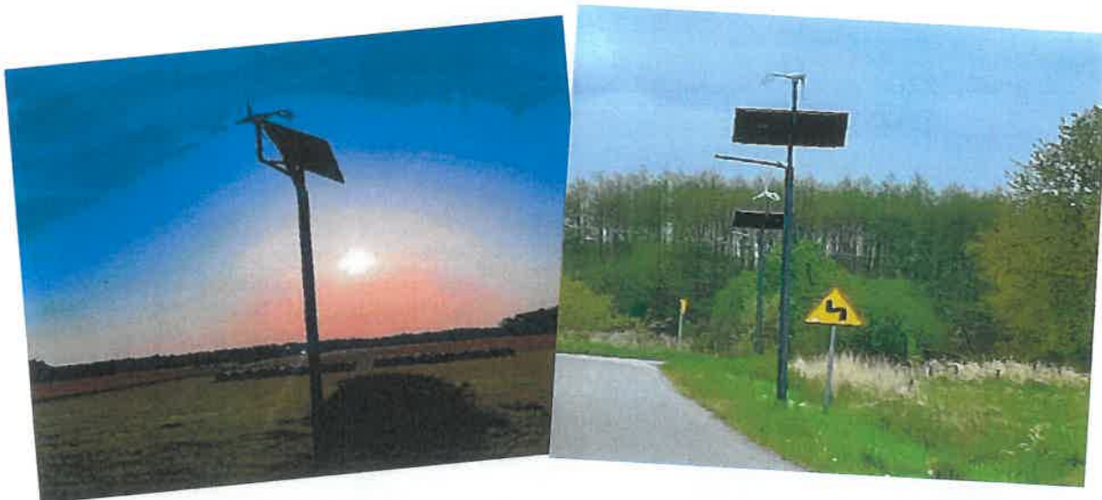
fot. modernizacja oświetlenia ulicznego w Gminie Świerzno
