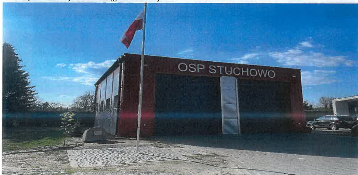
fot. budowa remizy Ochotniczej Straży Pożarnej w Stuchowie
