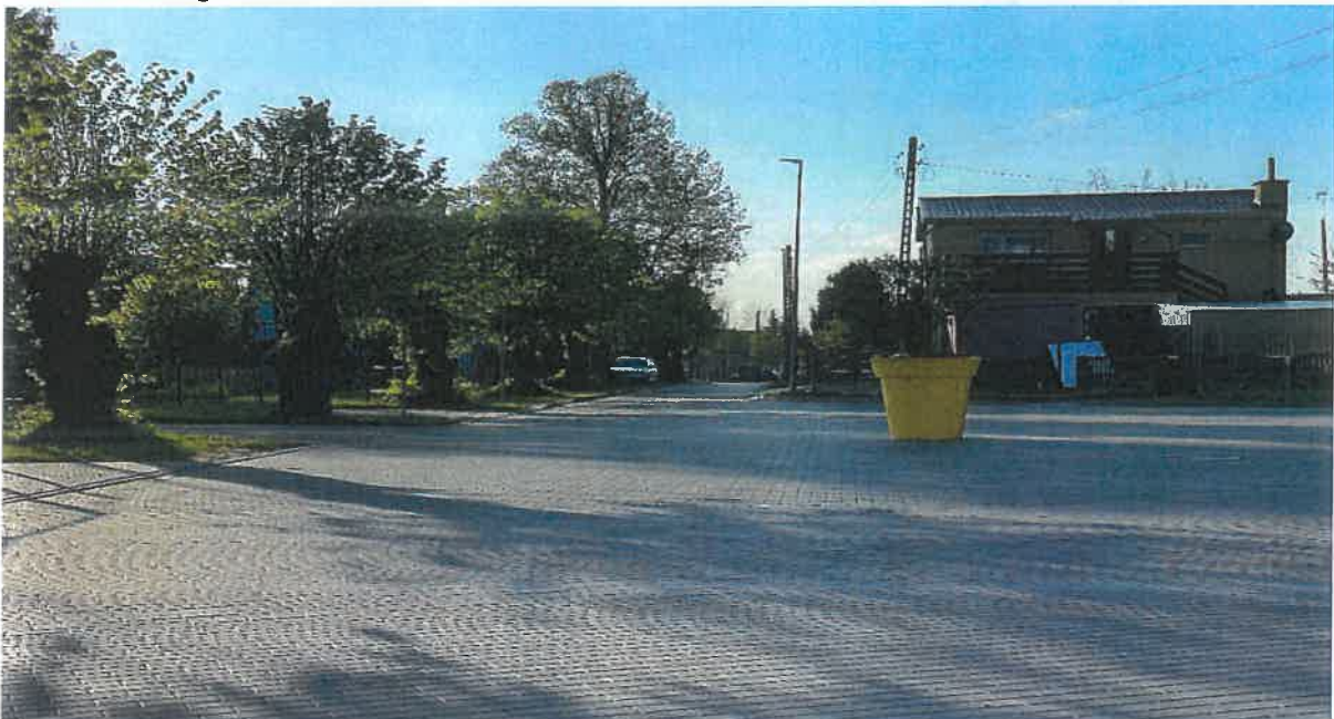
fot. przebudowa ul. Szkolnej w Świerznie
