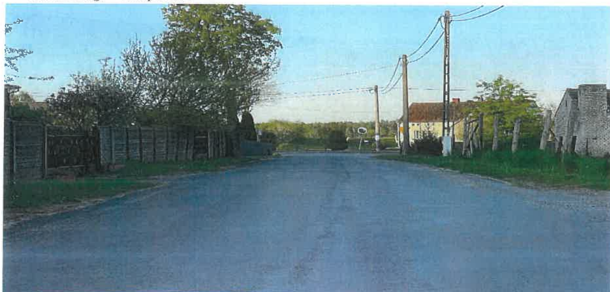
fot. remont drogi do pałacu w Ciesławiu
