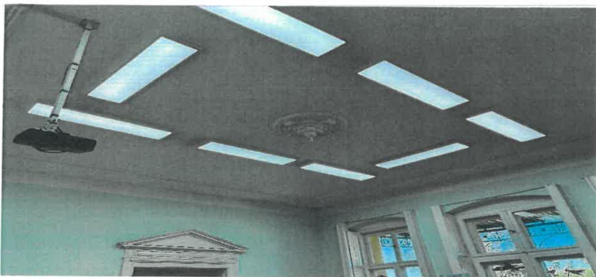
fot. modernizacja budynku Szkoły Podstawowej w Stuchowie
