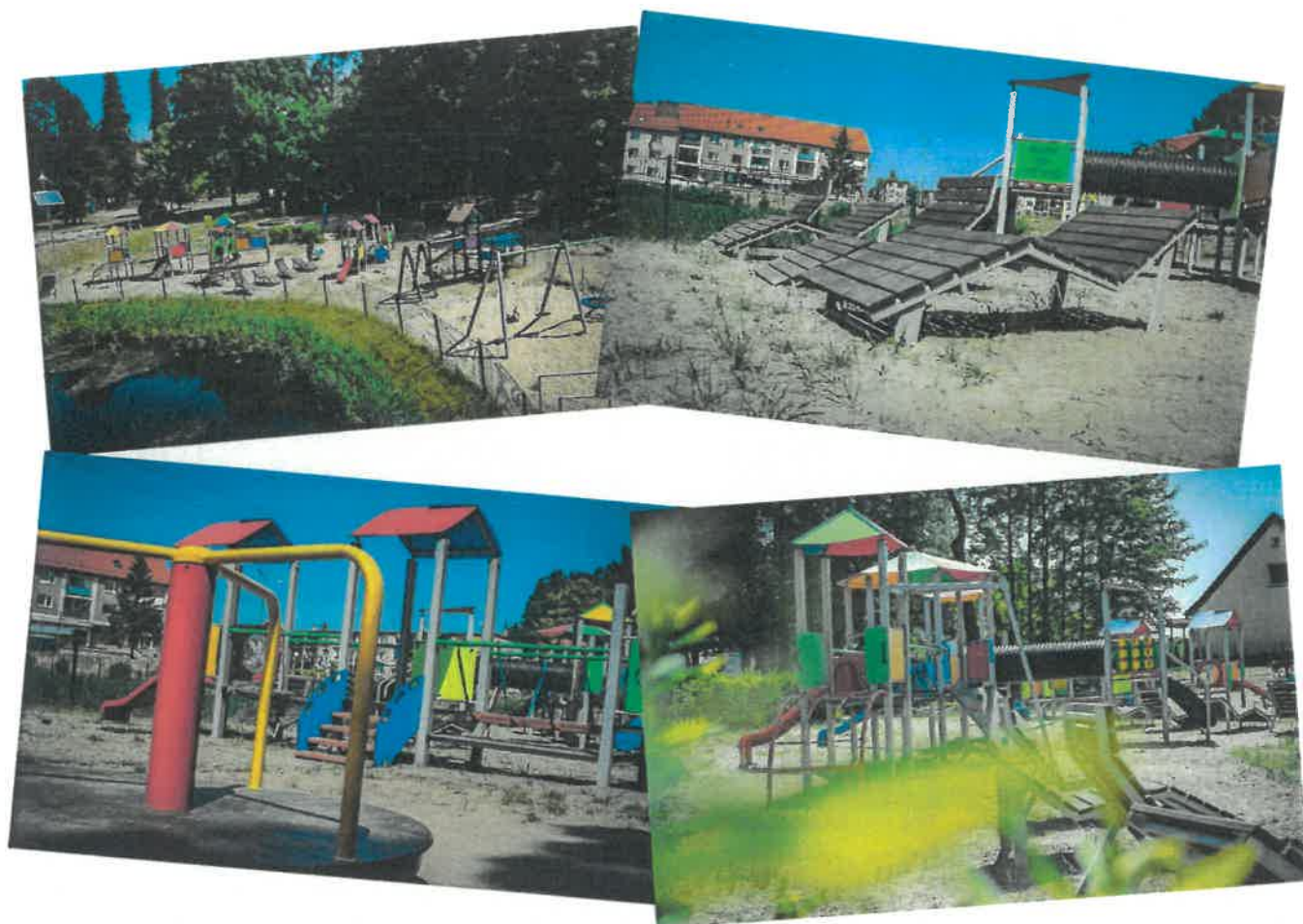
fot. budowa innowacyjnego ekologicznego miejsca rekreacji rodzinnej przy ul. Spacerowej w Świernie
