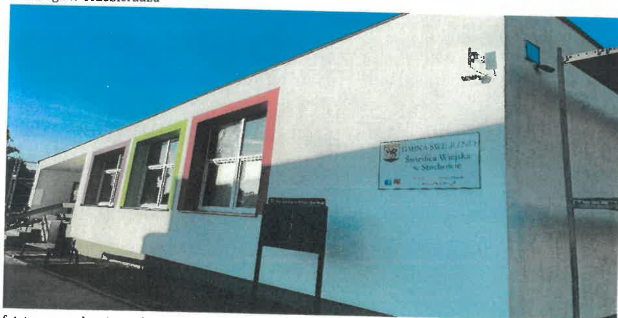
fot. termomodernizacja budynku świetlicy wiejskiej w Stuchowie
