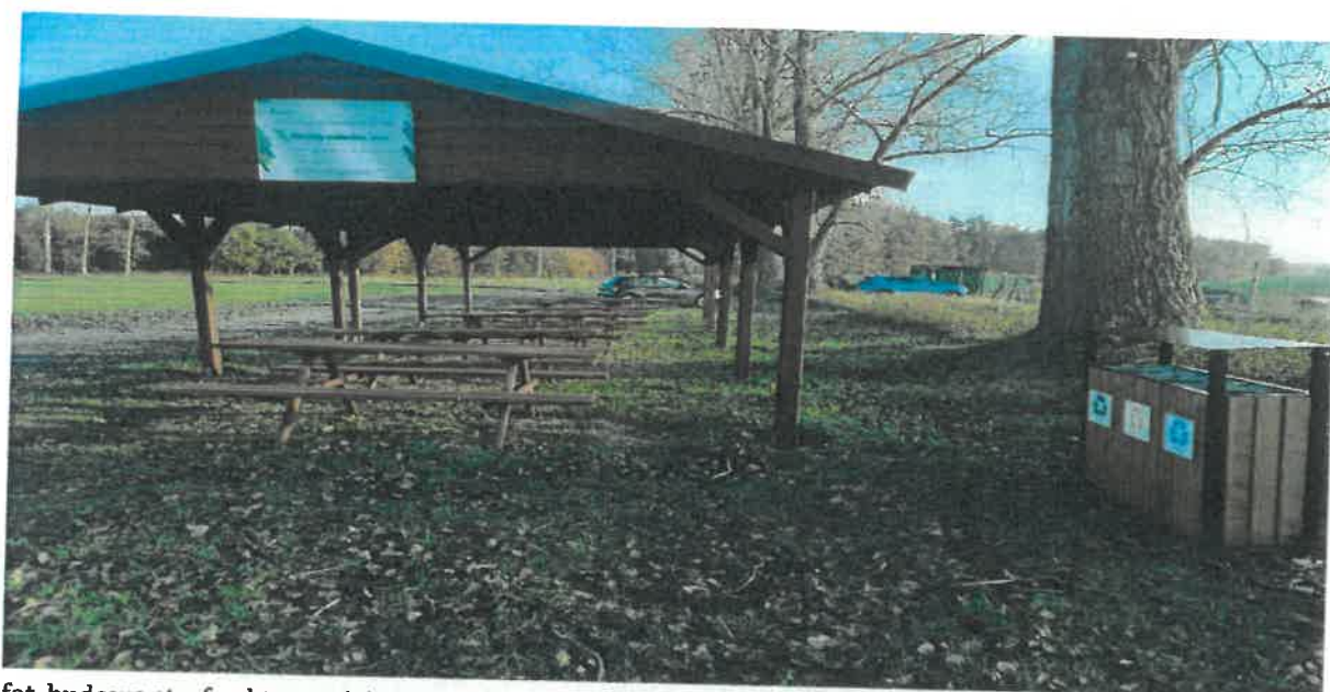
fot. budowa strefy aktywności – montaż wiaty na stadionie w Świerznie (grant sołecki)
