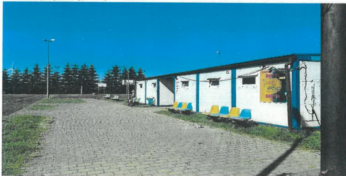
fot. przebudowa szatni sportowej w Gostyniu
