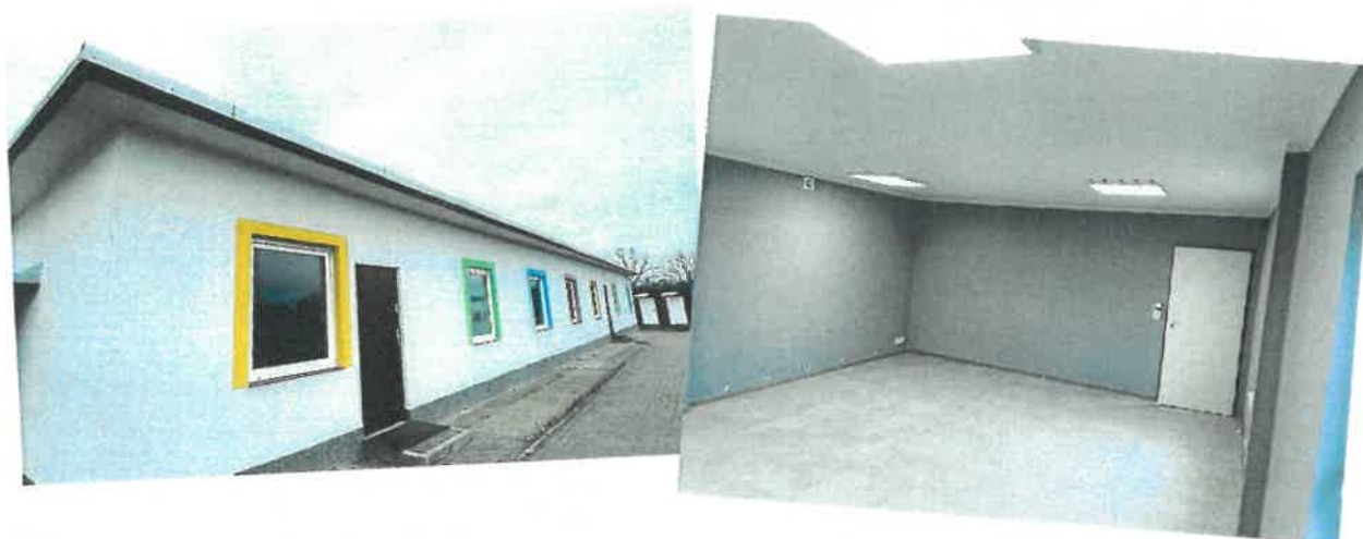
fot. przebudowa szatni sportowej w Stuchowie
